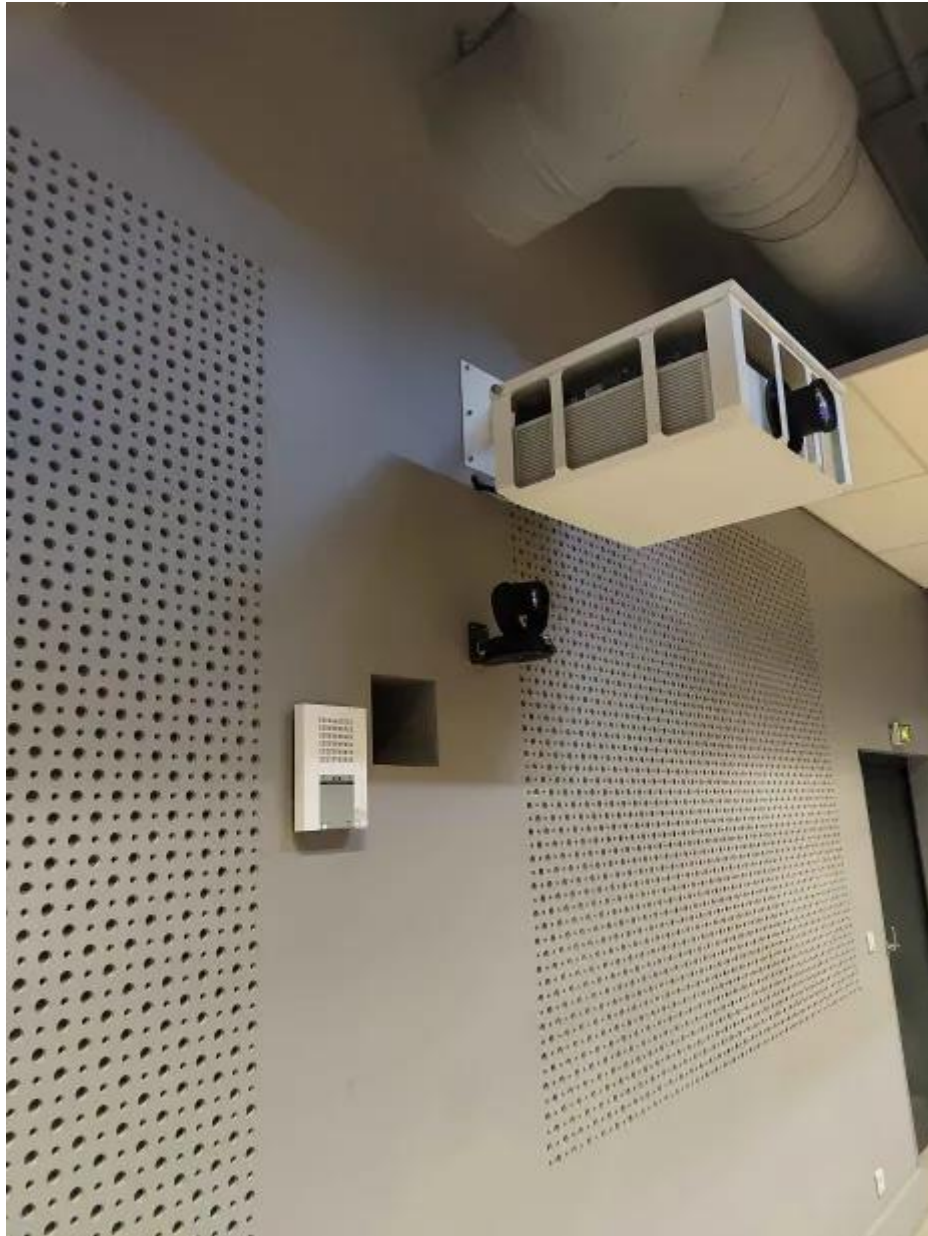
CAISSON ANTIVOL INSTALLÉ À L'EXTÉRIEUR DE RÉGIE
